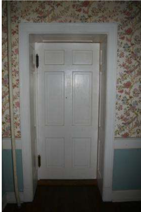
Room 102, Door 2, T. McDonald
