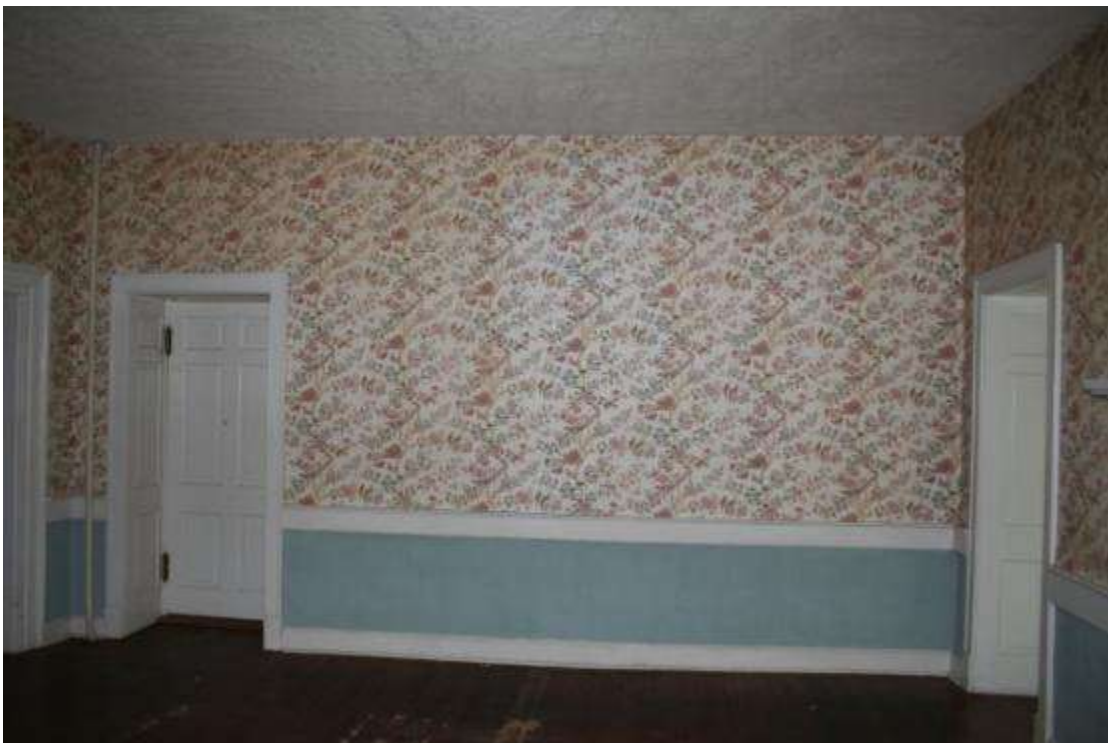
Room 102, east wall, door 2 & door 3, T. McDonald
