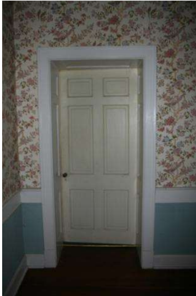
Room 102, door 3, T. McDonald
